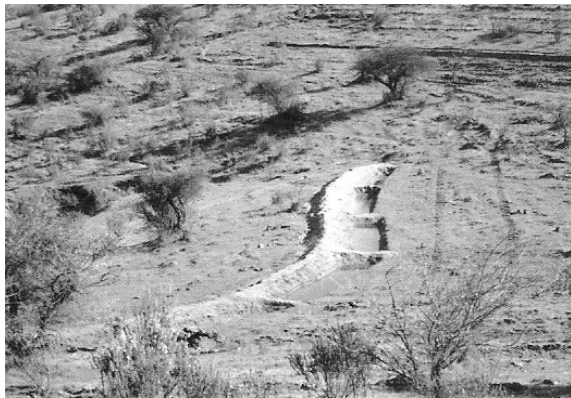
FOTO 4 – Wateropvanggrachten op stenige hellingen in een semi-aride streek in Chili
